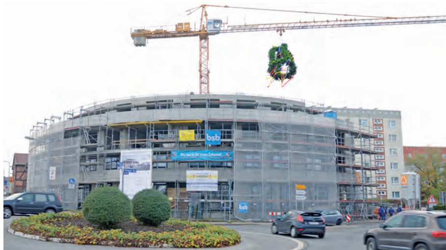
10.11.2016 – Richtfest an unserem neuen Wohn- und Geschäftshaus
