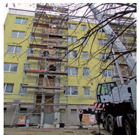
Der Anbau der Fahrstühle ist im vollen Gang
