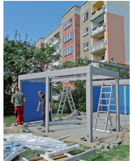
Montage der Fahrradhäuser in der Moskauer Straße 9 und 10
