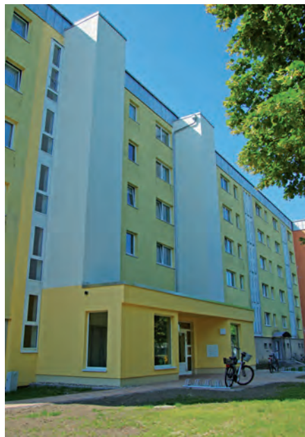
Die neuen altersgerechten Aufzüge in der Berliner Straße 1
